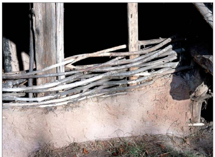
Abb. 2: Teilweise mit Lehm verstrichene Flechtwerkwand.
