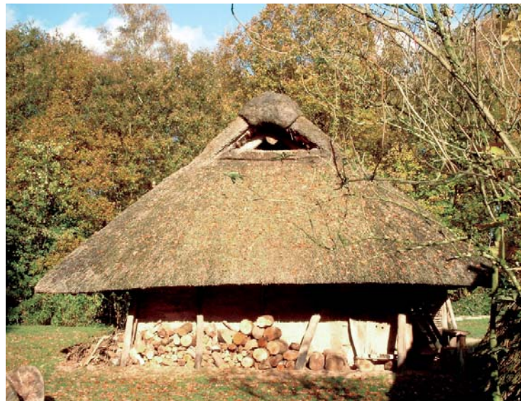
Abb. 6: Giebelansicht eines Hauses mit gut erkennbaren, schräg stehenden Außenpfosten.
