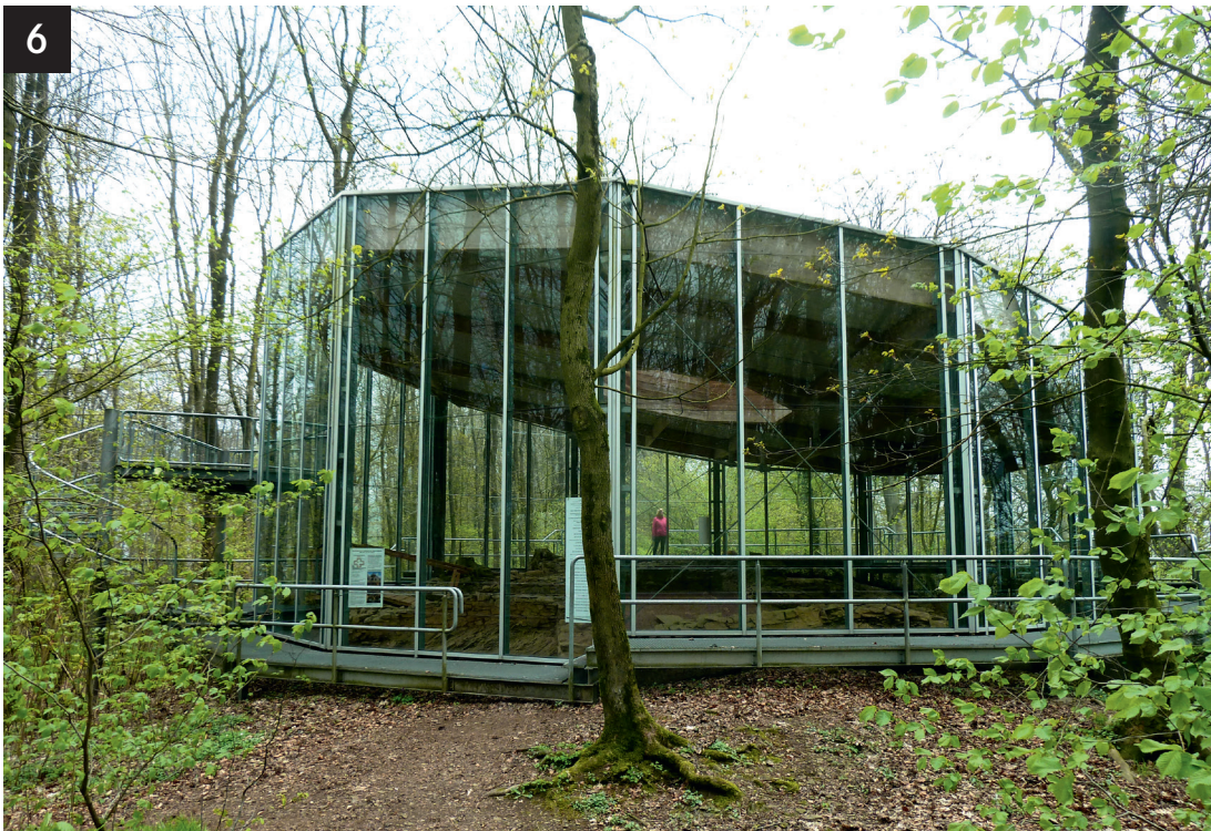
Abb. 6 | Der über der Kreuzkirche errichtete Schutzbau, Blick vom Westen. Zustand Frühjahr 2017.
